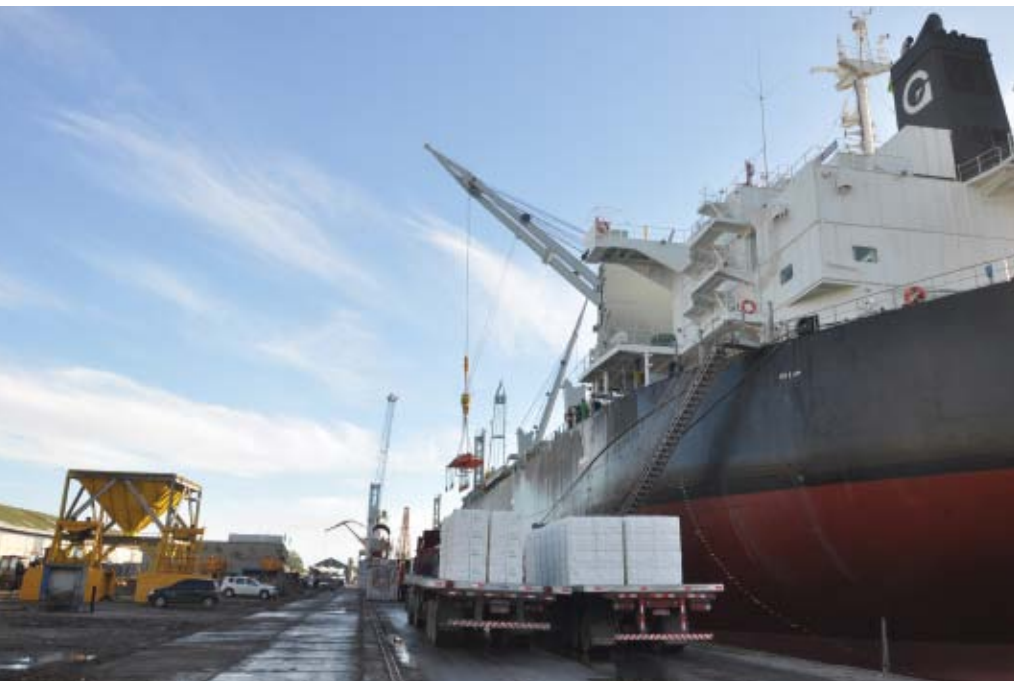
Rio Grande: duas importantes obras, em andamento, irão incrementar a estrutura portuária
