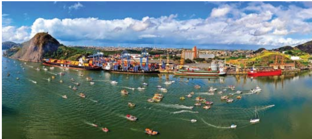
Está em implantação no porto de Vitória o sistema de gerenciamento do tráfego de navios
