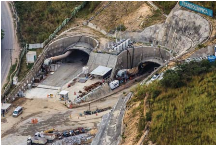
As obras do BRT Transolímpica incluem dois túneis na serra do Engenho Velho
