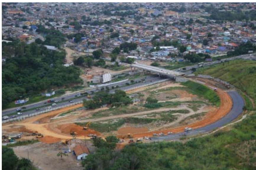
As obras do corredor Transbrasil, com 32 km, serão concluída em 2017
