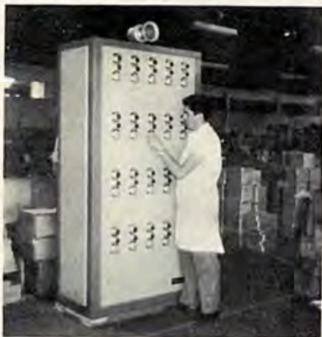
Painel à prova de explosão, com sinalização visual e sonora, para 20 níveis de tanques de produtos inflamáveis.
