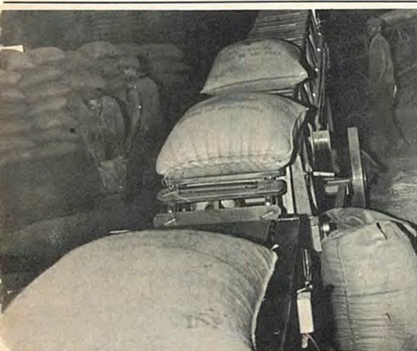
Cargas que não podem ser paletizadas: a melhor solução é o transportador.
