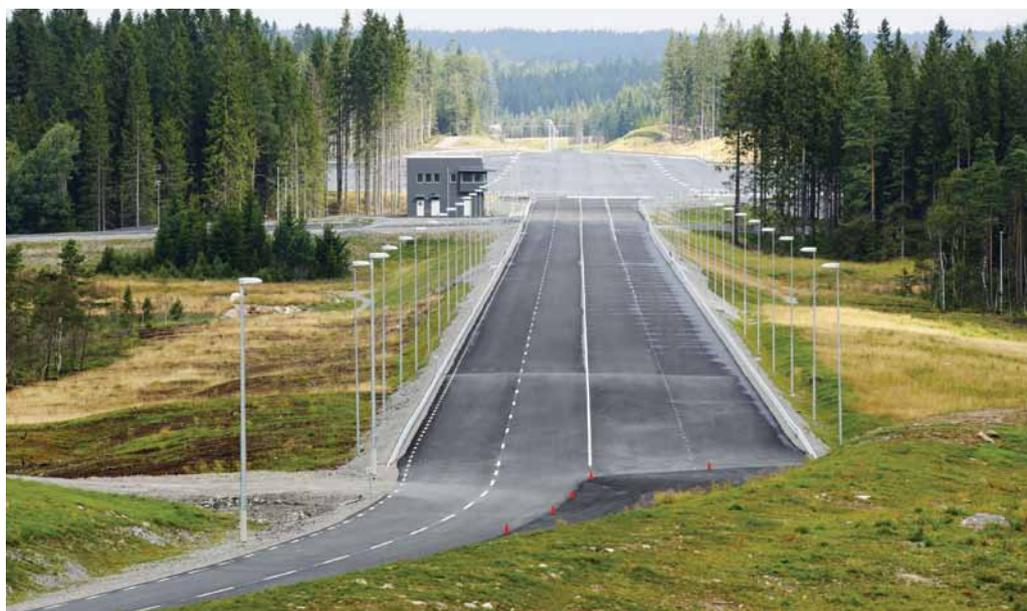
**A pista com múltiplas faixas, de alta velocidade, serve para testar o sistema de frenagem controlado eletronicamente**
