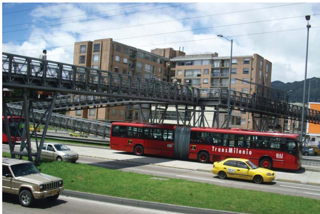
No sistema a instalação de passarelas de pedestre permite acelerar o fluxo dos ônibus
