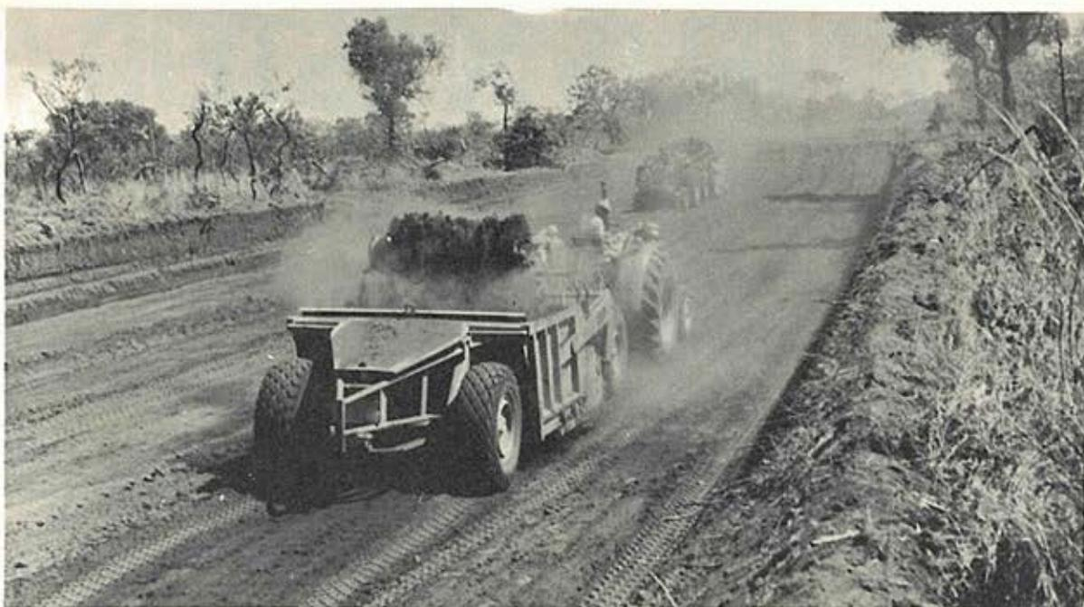
Os tratores de pneus de quatro rodas com vagão, ou de duas rodas (motoscrapers), foram das primeiras máquinas rodoviárias que substituíram as tracionadas por esteiras.
