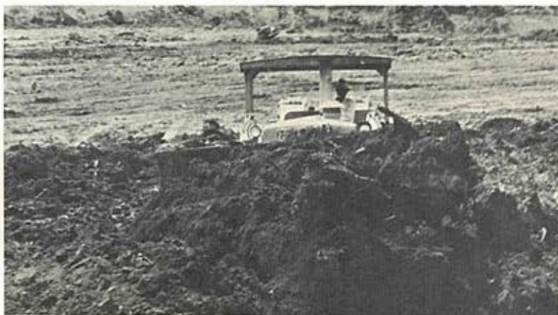
seu emprêgo como **scraper**, no transporte de terra, com plaina de arrasto para acabamento e para rebocar toda sorte de implementos. Todavia, logo surgiu o trator de pneus, de quatro rodas com vagão, ou de duas rodas (**motoscraeper**), que passou a ser usado no transporte de terra, determinando a divisão dos serviços pelos dois tipos de equipamentos.
