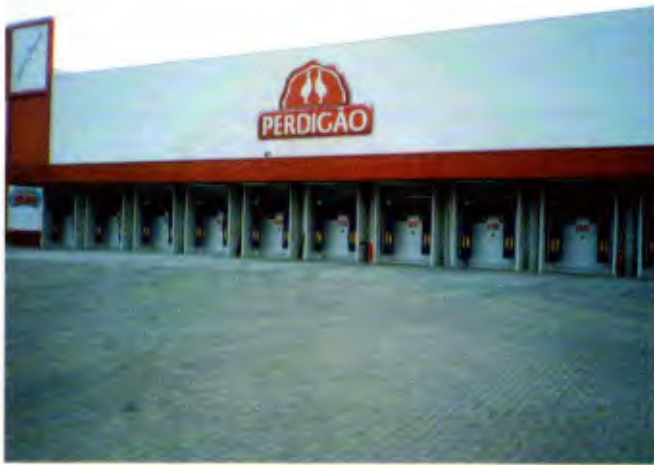
Cada módulo do CD tem 10 docas de carga e descarga com rampas niveladoras móveis
