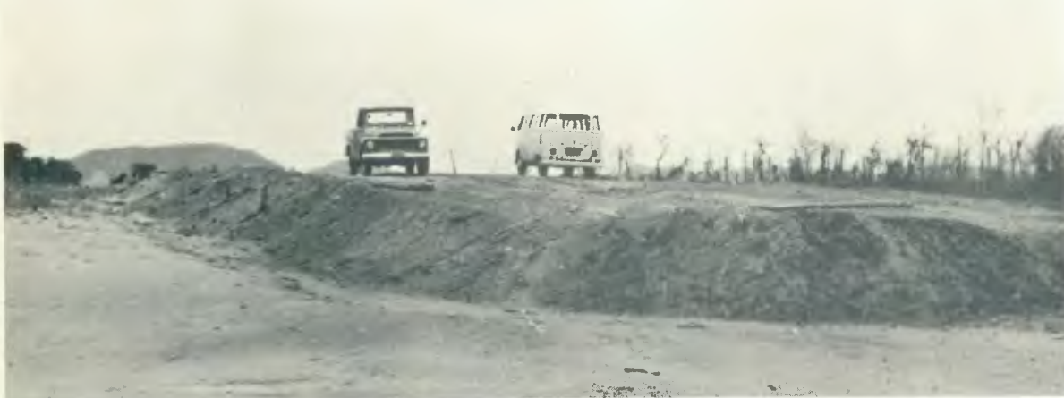
Sobre o atêrro hidráulico de areia, o de terra. Pela experiência da Cosipa, a estrada abaixará meio metro.
