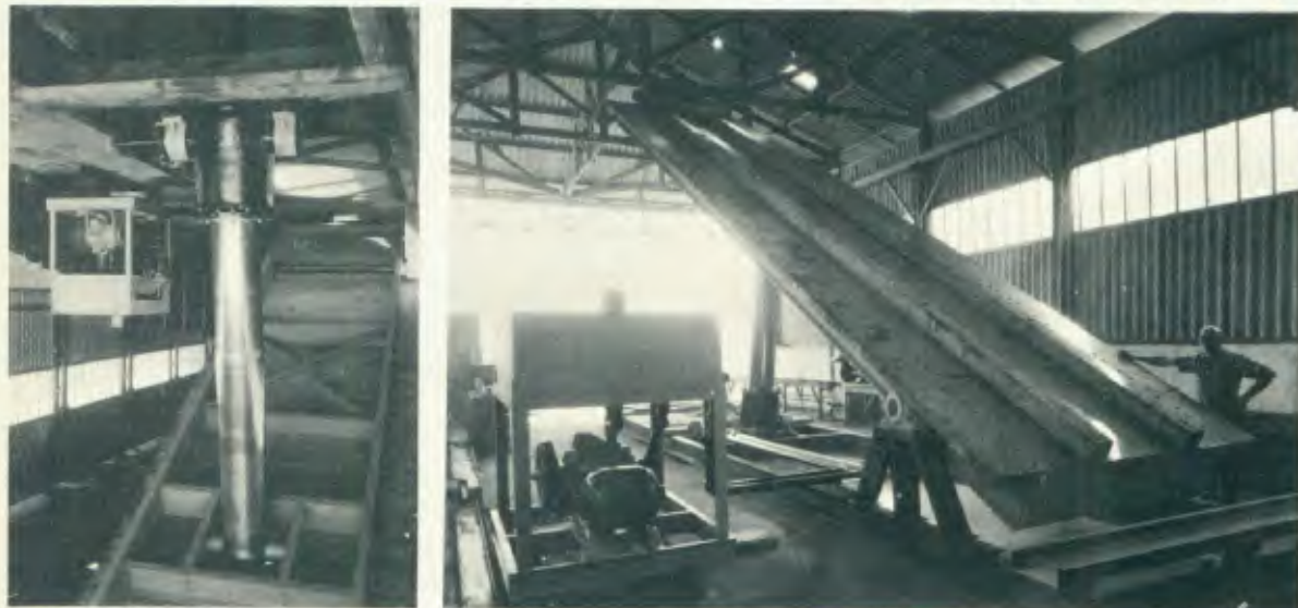
Com estas plataformas, o caminhão que leva material a granel pode ser comum para descarregar como basculante.
