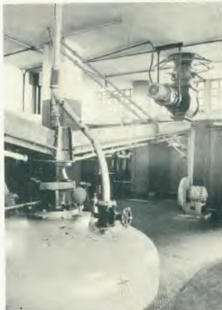
Retirada do cimento dos silos para pontos de operação: uma aplicação do sistema.
