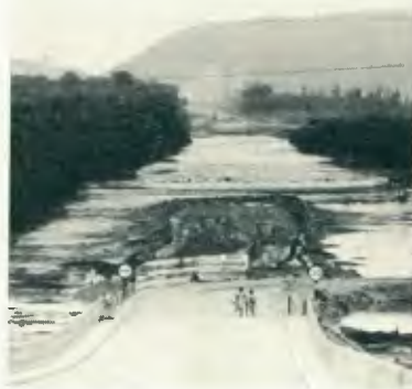
A entrada de areia no canal torçou as estacas de apoio da ponte.
