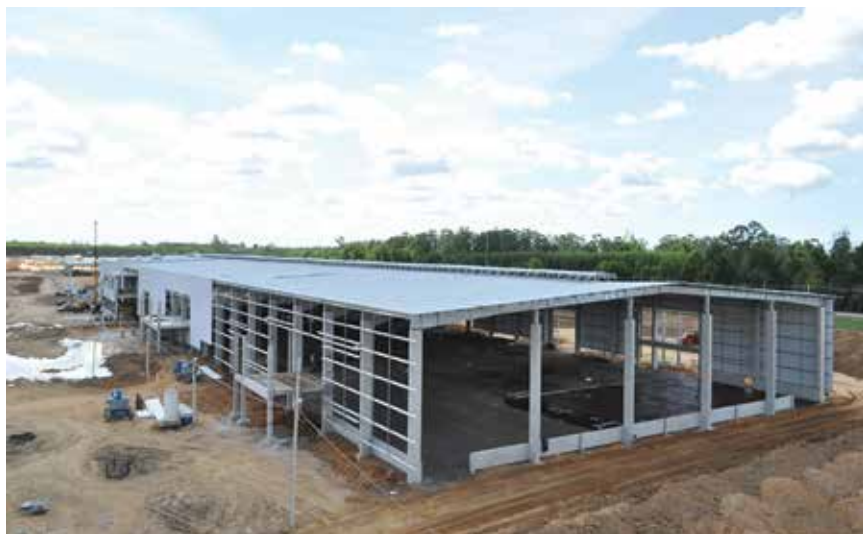
O primeiro prédio de 10 mil m 2 da nova fábrica está sendo construído
