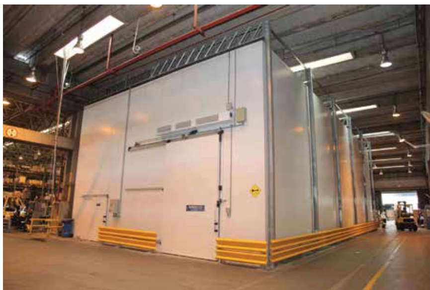
A nova câmara fria de exportação tem volume de 1,7 mil m 3 para armazenagem
