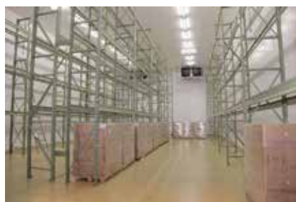
Além de possuir capacidade para 220 posições, a câmara fria mantém a temperatura entre 2° C e 8° C
