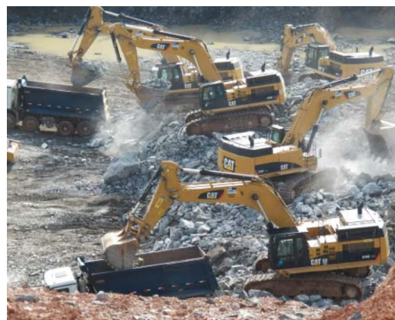
Serão utilizadas 2.500 máquinas nas obras
