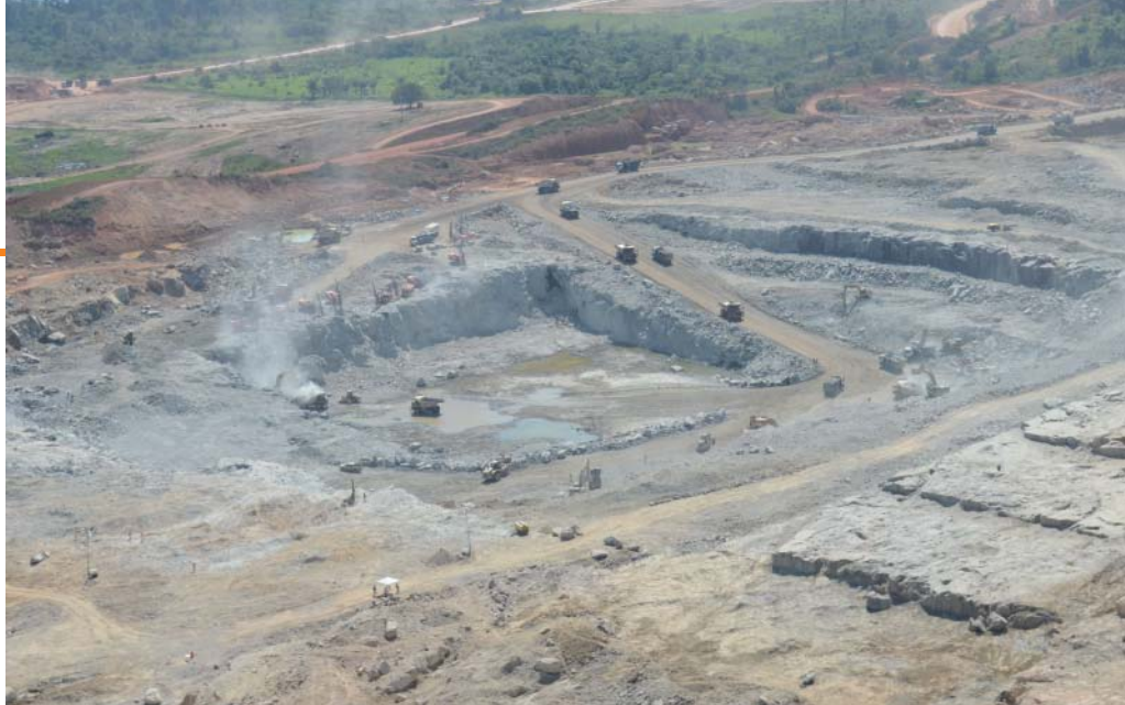
Belo Monte já tem quatro frentes de trabalhos, com intensa movimentação de terra
