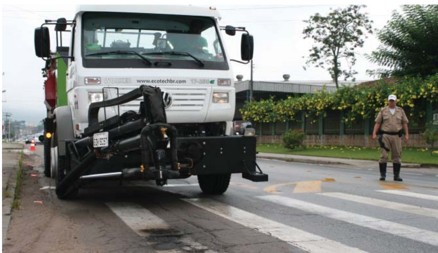
O método de trabalho na reparação e conservação de estradas veio dos Estados Unidos
