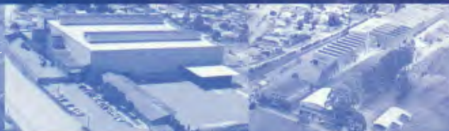
FUNDAÇÃO I DE FERRO
