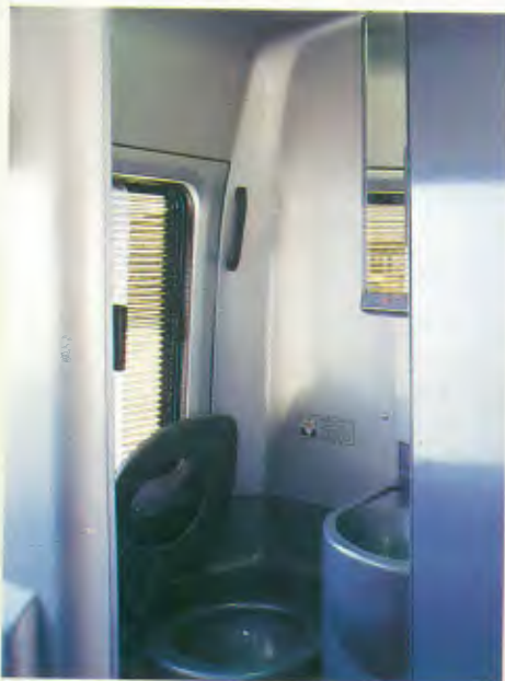
WC instalado sobre motor traseiro
