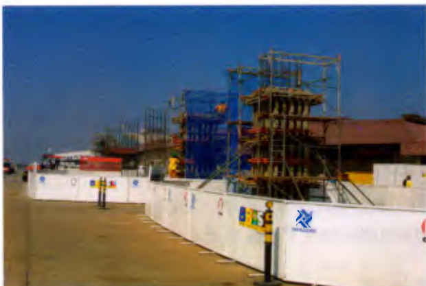
Obras de fingers iniciadas em Congonhas
