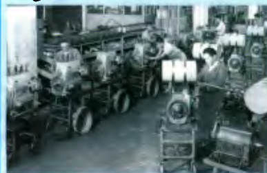
Linha de montagem do K12, primeiro motor da MWM do Brasil, em 1953
