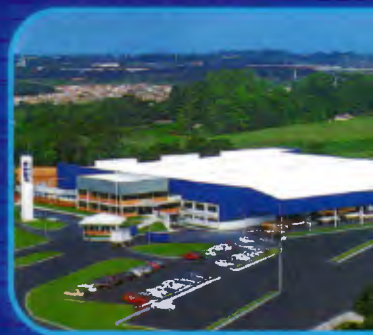
UNIDADE DE USINAGEM
