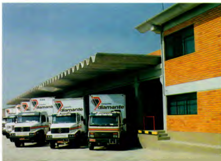
Terminal permite operação simultânea de 38 veículos
