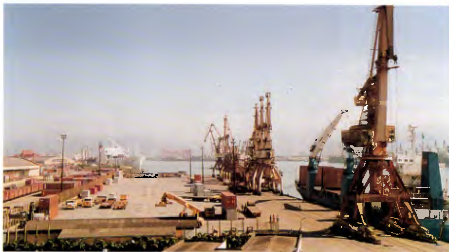
Terminal 37: nos próximos 20 meses, metade da área estará em obras
