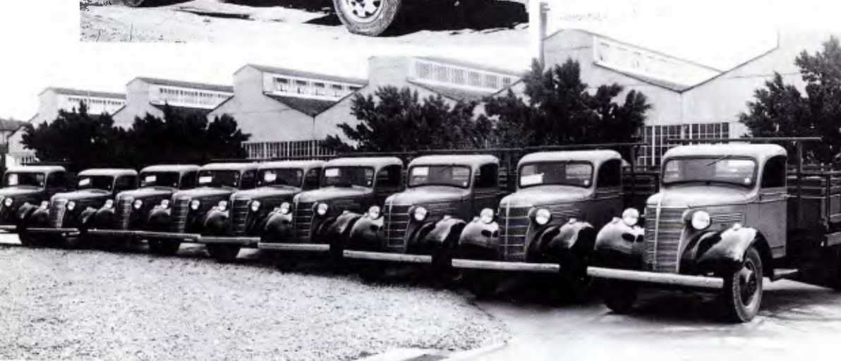
Modelos fabricados nos EUA, nos anos 30 e montados no Brasil: o buldogue, ano 38, o GMC versão militar, ano 41 e uma frota de Chevrolet Tigre, ano 37 com motor a gasolina, dotado de pescador e sem lubrificação forçada
