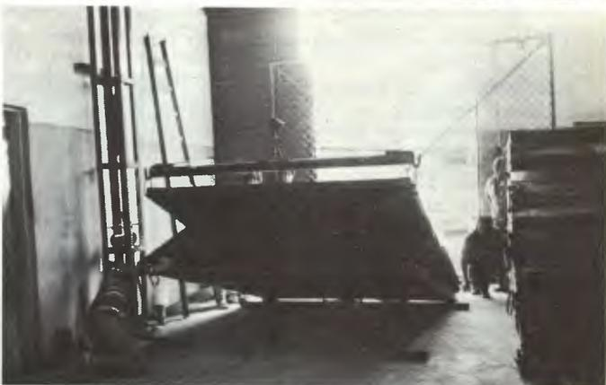
Montado em chapas, o contêiner é fechado por compensado
