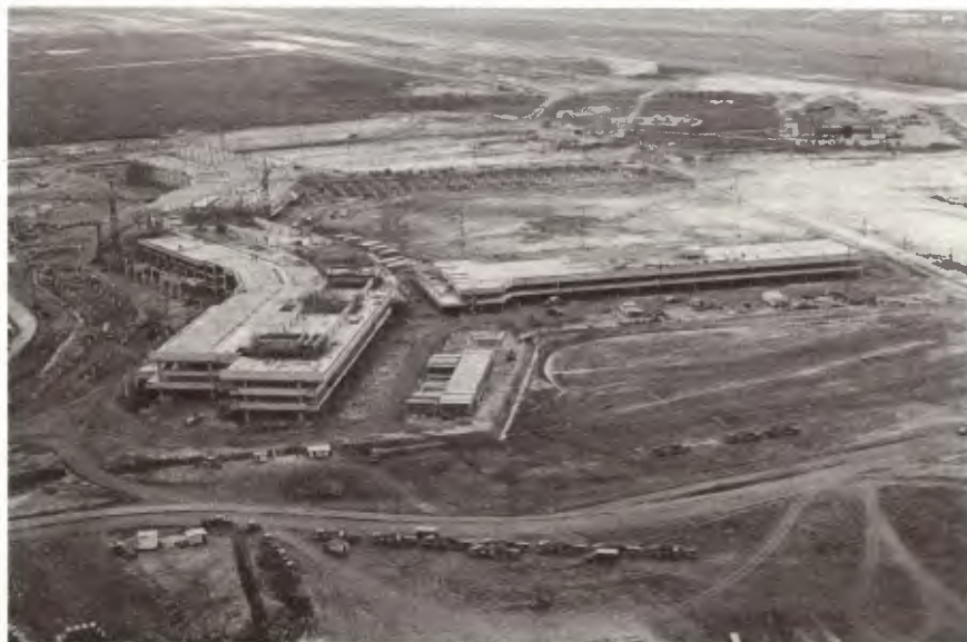
As obras do novo aeroporto paulistano já estão bem adiantadas
