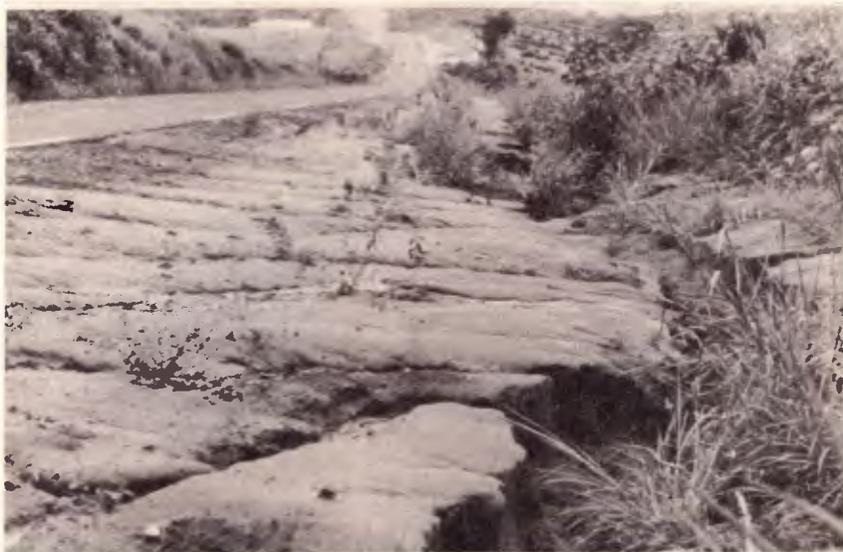
A falta de revestimento expõe o solo à ação destruidora das intempéries.
