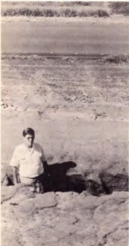
As profundas erosões inutilizam os acostamentos.
