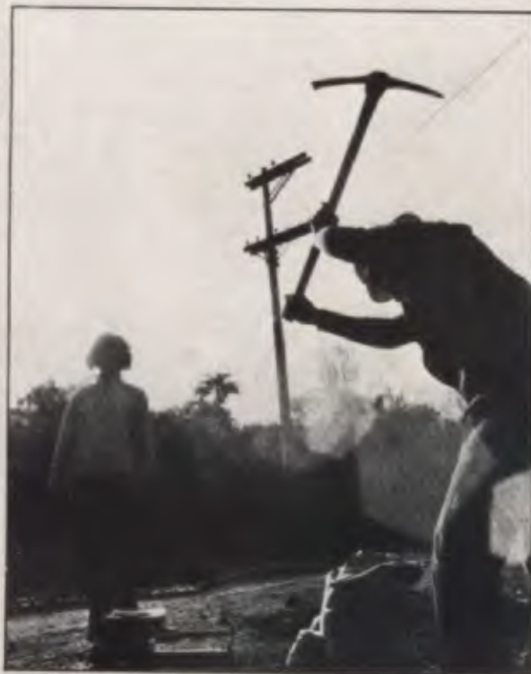
Uma maneira de coletar amostras: saca de lona branca e instrumento manual.
