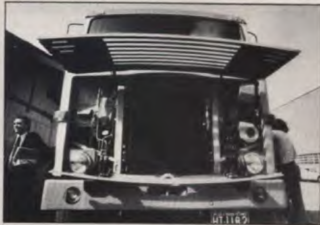
Grade frontal se abre para exame de água e óleo
