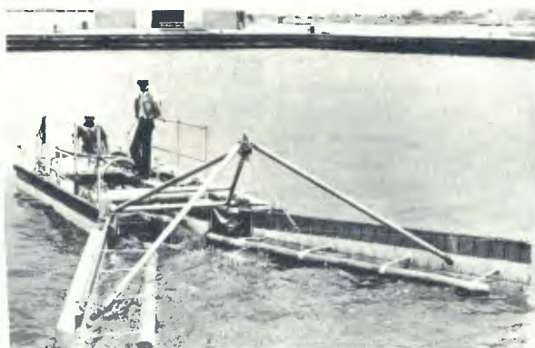
A barcaça-escumadeira retira óleo das águas poluídas.
