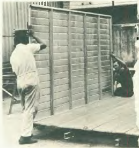
Início: a primeira lateral é colocada.
