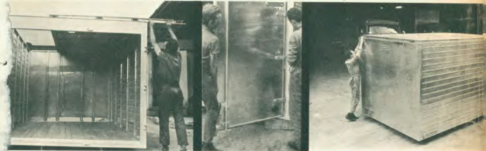
O teto não é problema. Depois, basta colocar as portas e está pronto o furgão. Tempo de montagem: uma hora.
