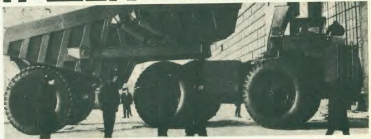
Belaz-549, gigantesco fora-de-estrada russo, movido a turbina. Com seus 850 HP, pode levar 123 t de carga.
