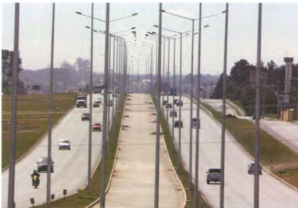
A nova avenida da Linha Verde terá vias marginais com três pistas cada, uma de cada lado da canaleta
