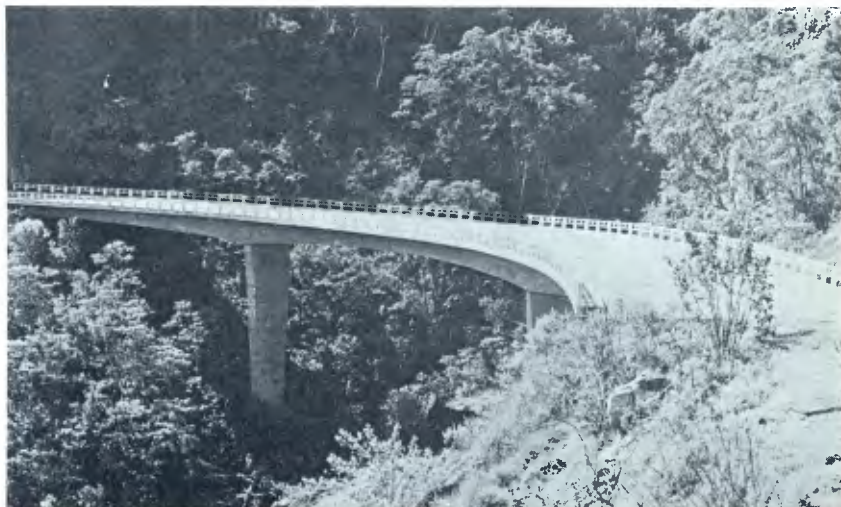
Já pronto, o viaduto Gavião Gonzaga será reaproveitado pela SP-123.
