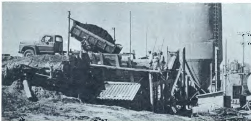
A usina pode produzir 150 t de solo-cimento por hora de trabalho.
