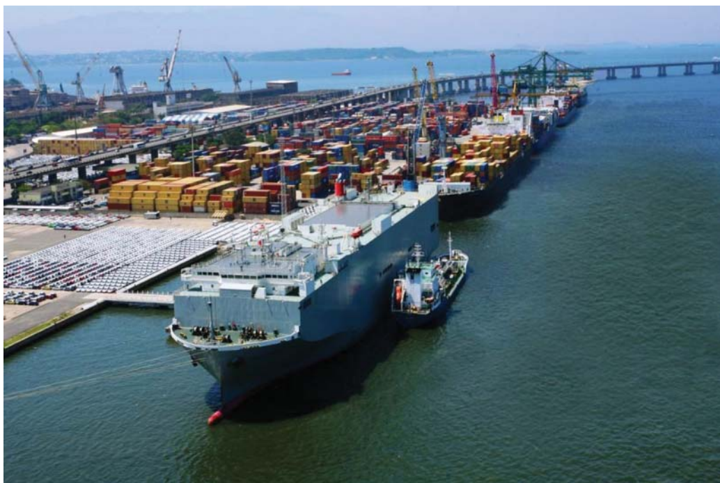
Ampliação e modernização atenderão ao aumento de cargas e às atividades do pré-sal
