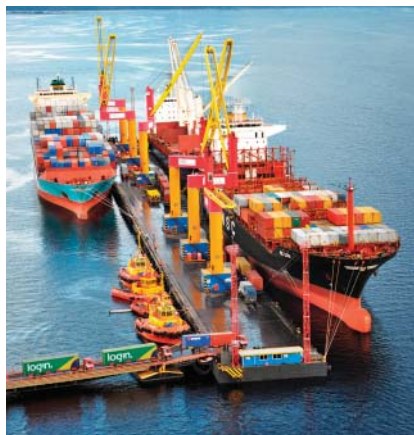
Cais flutuante tem extensão de 431 metros
