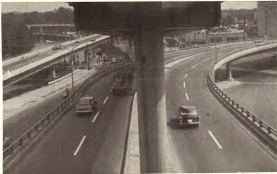
Pistas superpostas evitam cruzamentos e permitem conexão entre vias expressas
