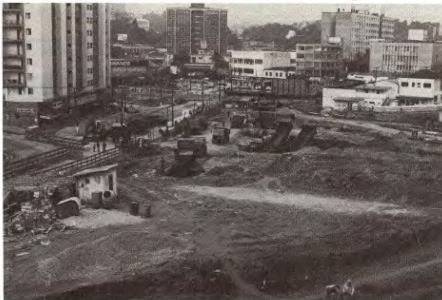
As obras do terminal de Diadema ainda estão em fase das fundações
