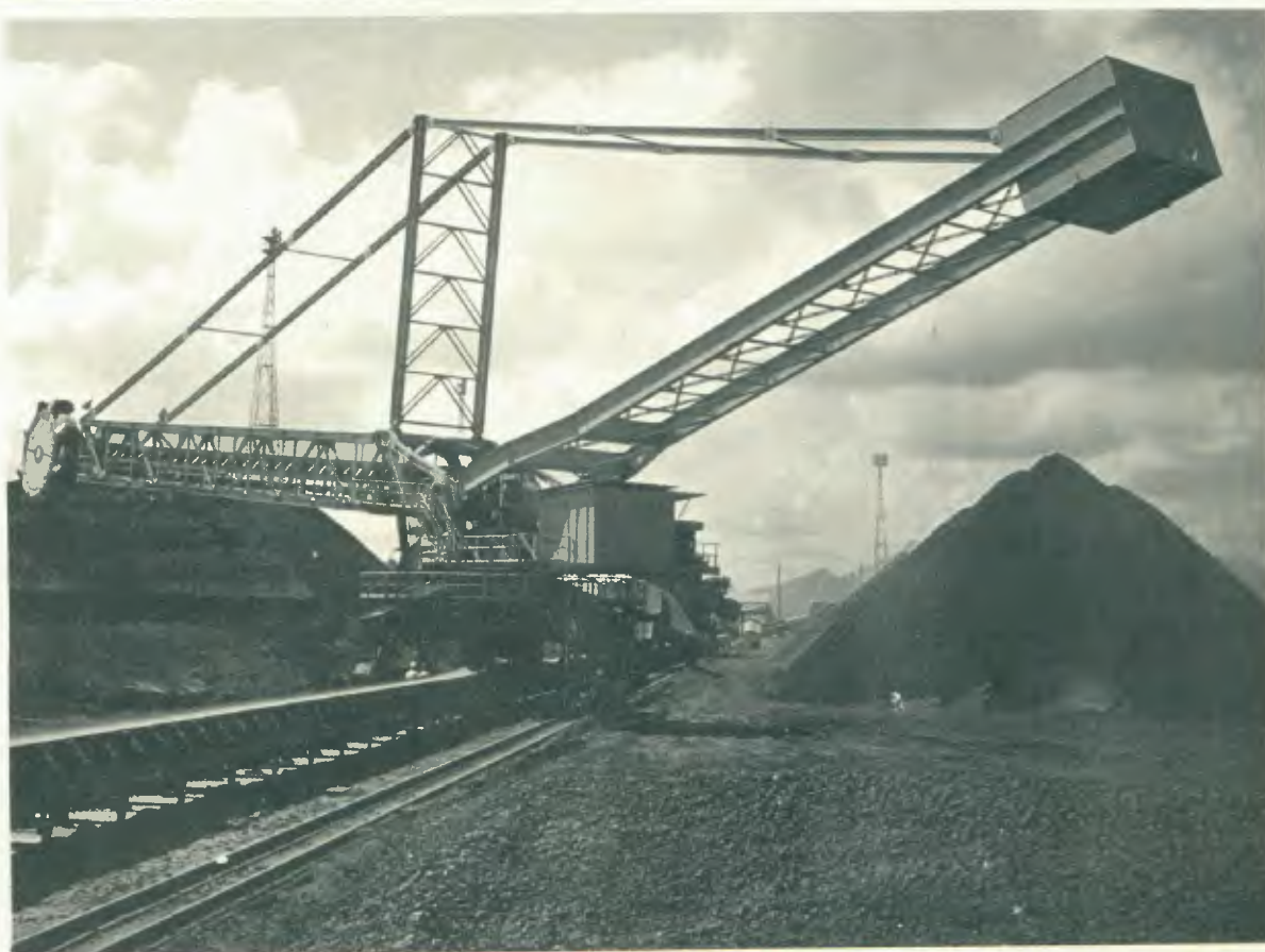
As "bucket-wheel" (escavadeiras de rodas com caçambas) recuperam o minério na área de armazenagem.
