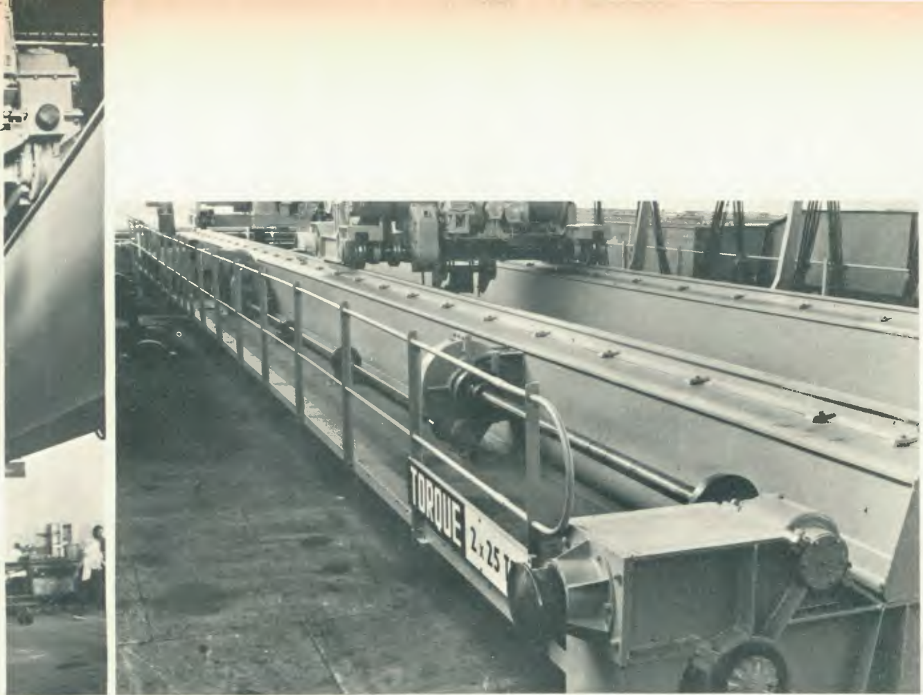
A operação é feita pouco abaixo do telhado, altura suficiente para não interferir na movimentação do piso.
