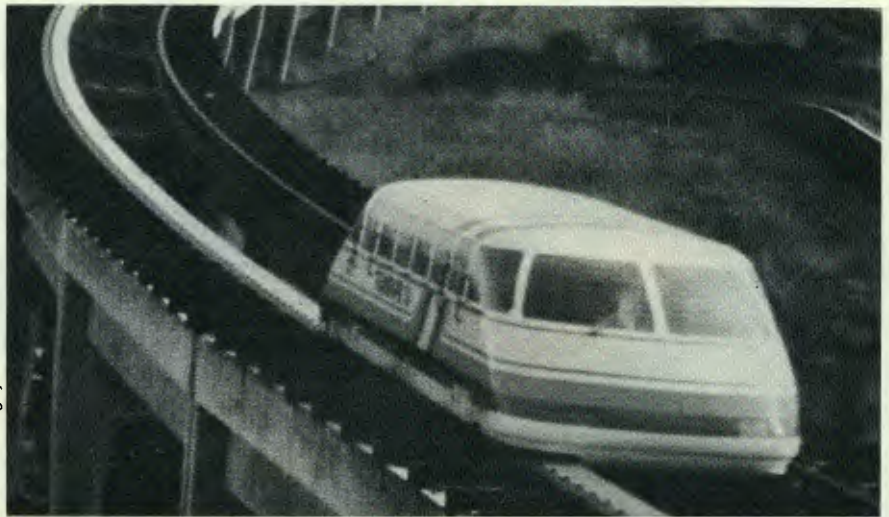
O Transrapid 04 ficou pronto em 1974. Tinha 20 t de peso e fazia até 253 km/h
