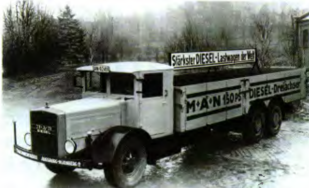
Caminhão MAN foi o primeiro veículo a usar, em 1927, a bomba de injeção Bosch
