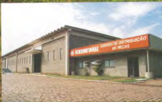
Centro de Distribuição de Peças - Nova Odessa/SP
