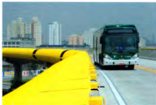
Expresso Tiradentes: via elevada do corredor de 32 km
