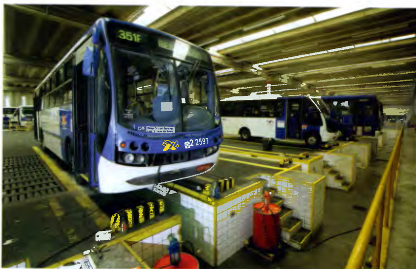
Sistema automatizado de abastecimento numa das 25 garagens do grupo
