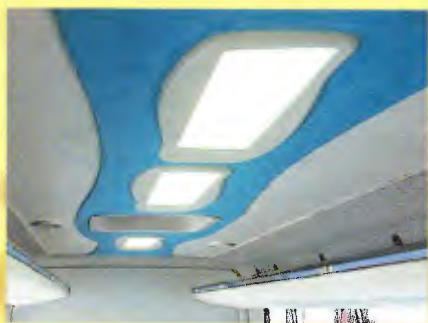
Opção de vários revestimentos no teto centro.
