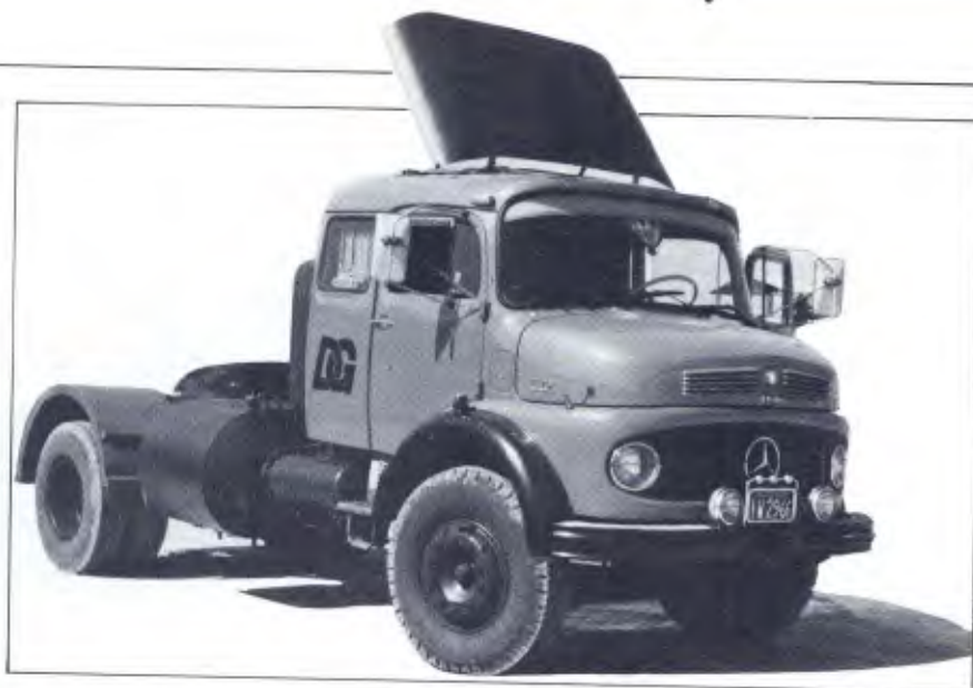
Segundo o fabricante, o spoiler economiza até 20% de combustível.
