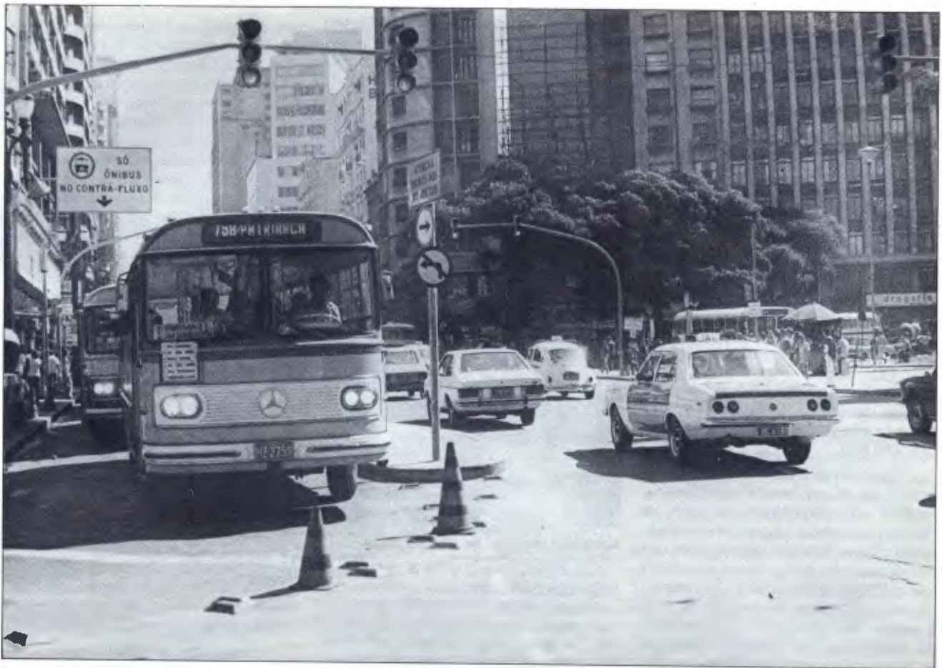
No local, o DSV colocou 66 prismas, 113 tachões, 151 placas e providenciou 1 190 m 2 de sinalização horizontal.
