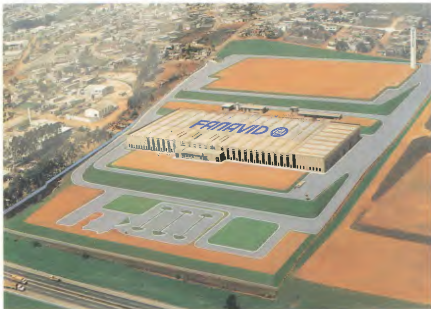
VIA DUTRA - SÃO PAULO
