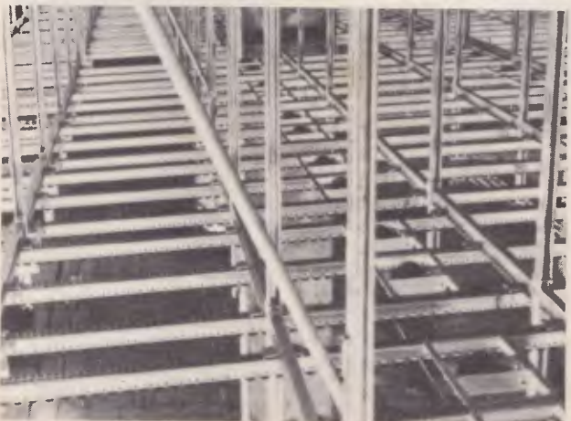
Os canais são divididos por estruturas metálicas.
