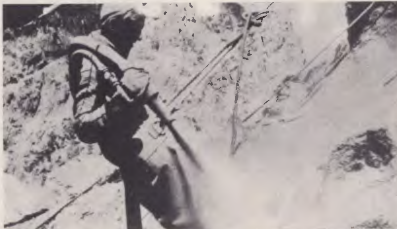
Através dos mangotes, o jateamento atinge os locais de difícil acesso
