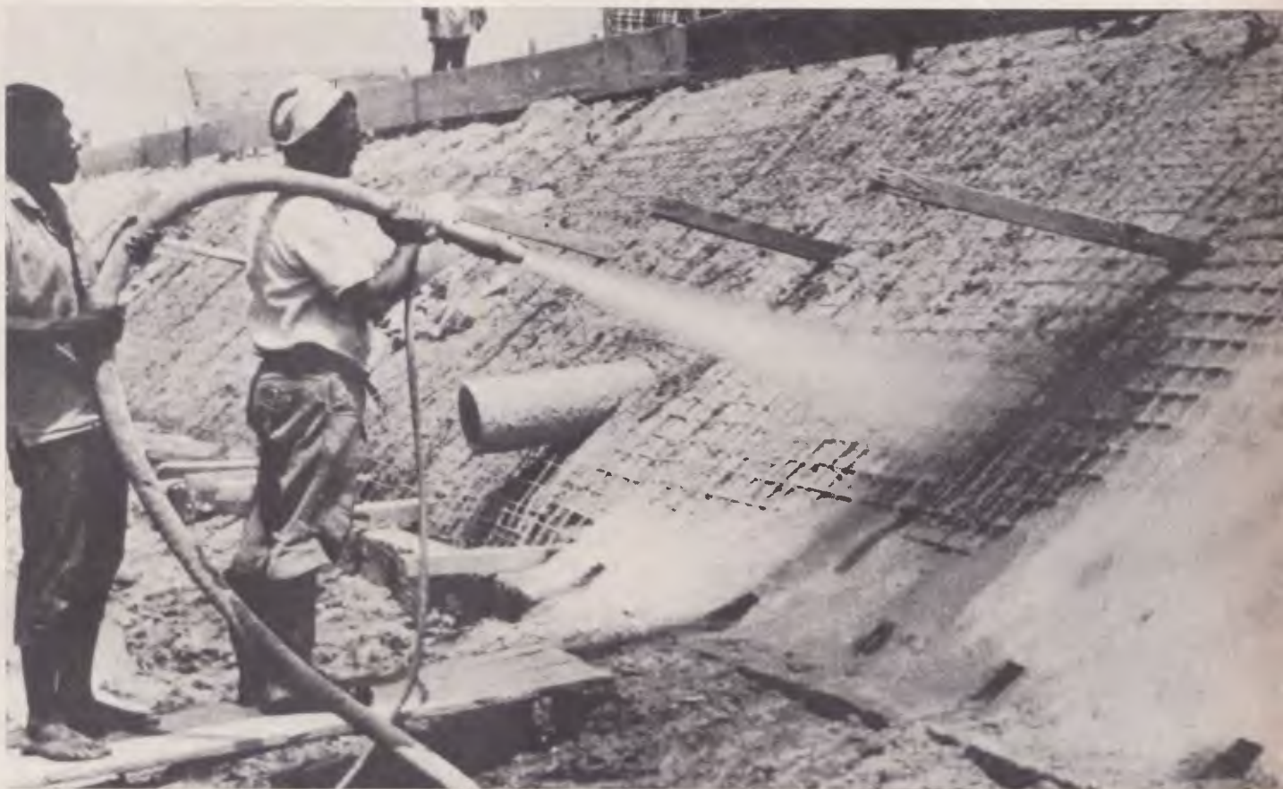
O método dispensa formas, economiza tempo no transporte e lançamento do concreto, reduzindo os custos da obra
