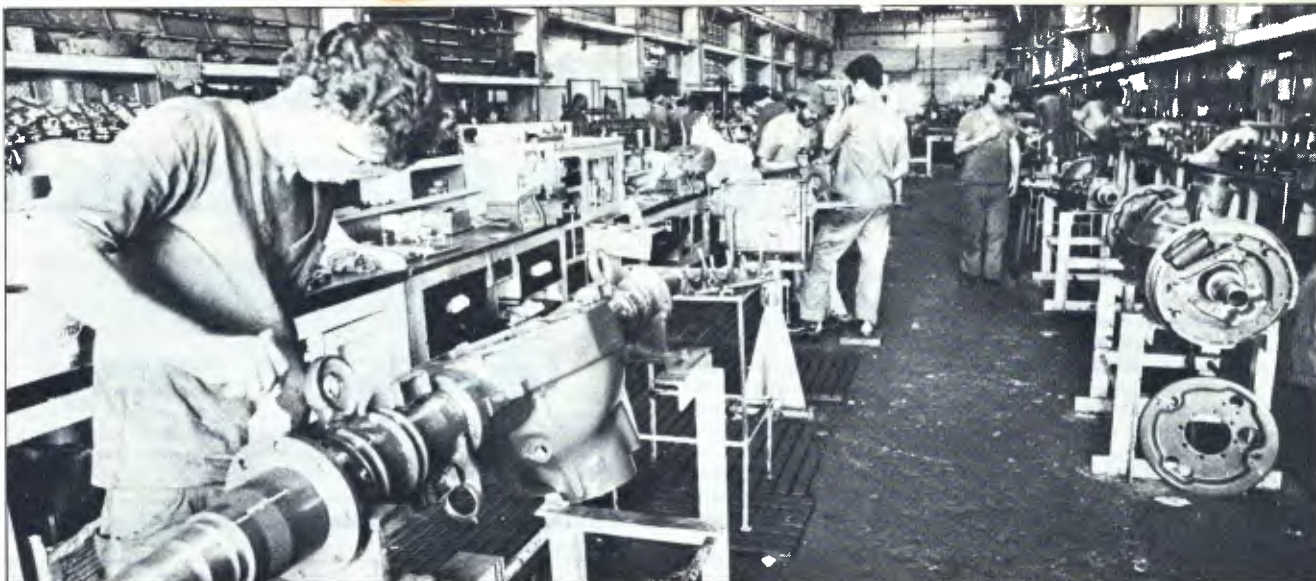
Oficina central: seção de usinagem pesada e montagem de eixos.
