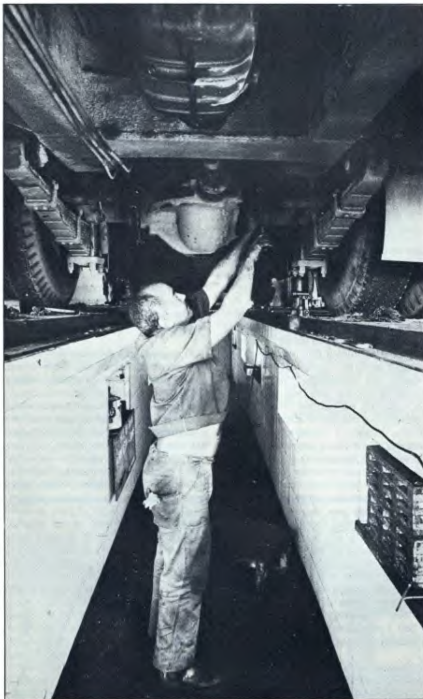
As valetas são bastante espaçosas e muito bem iluminadas.
