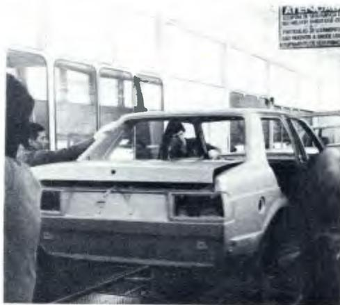
*A estação de pré-tratamento da VW, em São Bernardo, SP, é como a do desenho (ao alto): o carro passa por 10 estágios e chega ao final deles com uma camada de 2,5 a 3 gramas de fosfato de zinco. Em seguida o veículo entra num primer eletroforético (na extrema esquerda o processo catódico, que a empresa terá funcionando em agosto). Na aplicação do esmalte final, a VW diz que "o homem não será substituído pelo robô ao menos a curto e médio prazo".*
