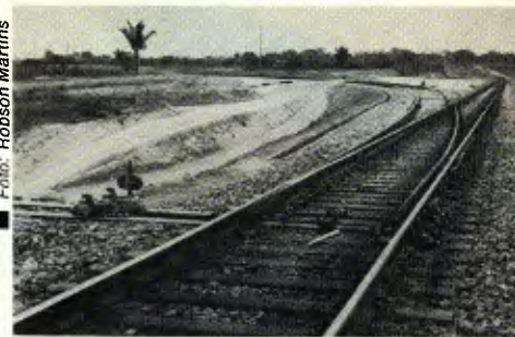
Norte-Sul: construção de mais 136 km
