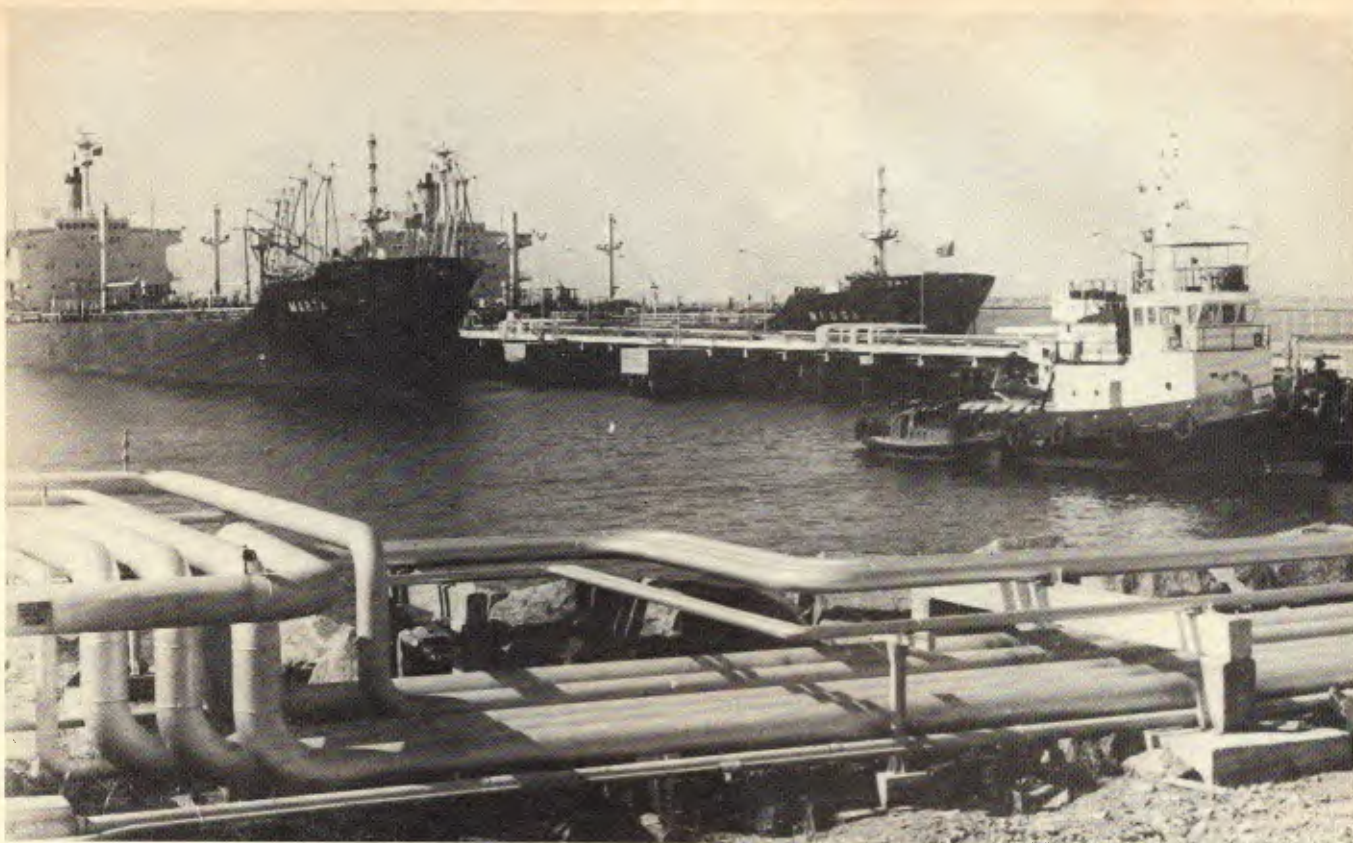
O pier de granéis líquidos e gasosos de Suape carrega simultaneamente dois navios de até 30 mil tpb
