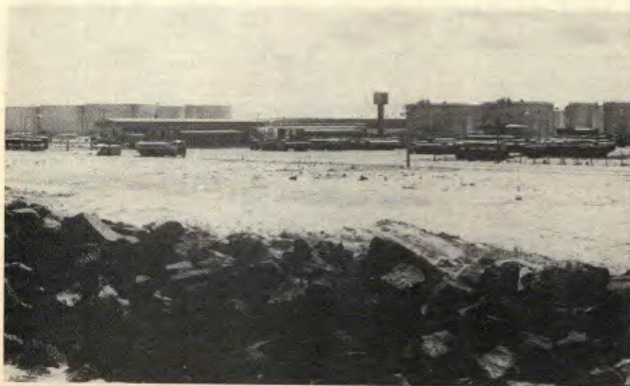
Área de armazenamento de granéis líquidos: 175 mil m 3 em 63 tanques
