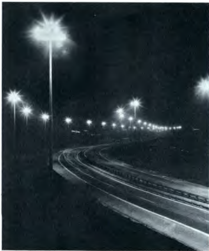
Na Imigrantes, células fotoelétricas comandam a adaptação do nível interno de iluminação às condições externas para facilitar a adaptação visual do motorista. O iluminamento utilizado na Anchieta é muito superior ao recomendado pelas normas.
