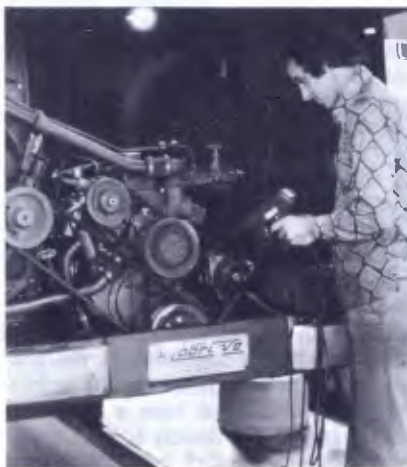
O aparelho da Sun indica o avanço ou atraso de injeção.
