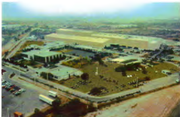
Fábrica de Monterrey, México: 74% brasileira, 26% alemã
