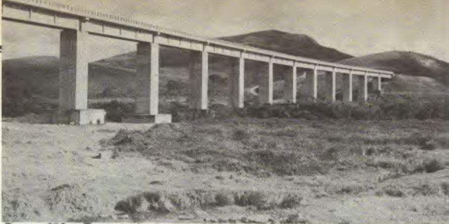
Desde 1978, a Ferrovia do Aço tem 88% das obras de infra-estrutura concluídas
