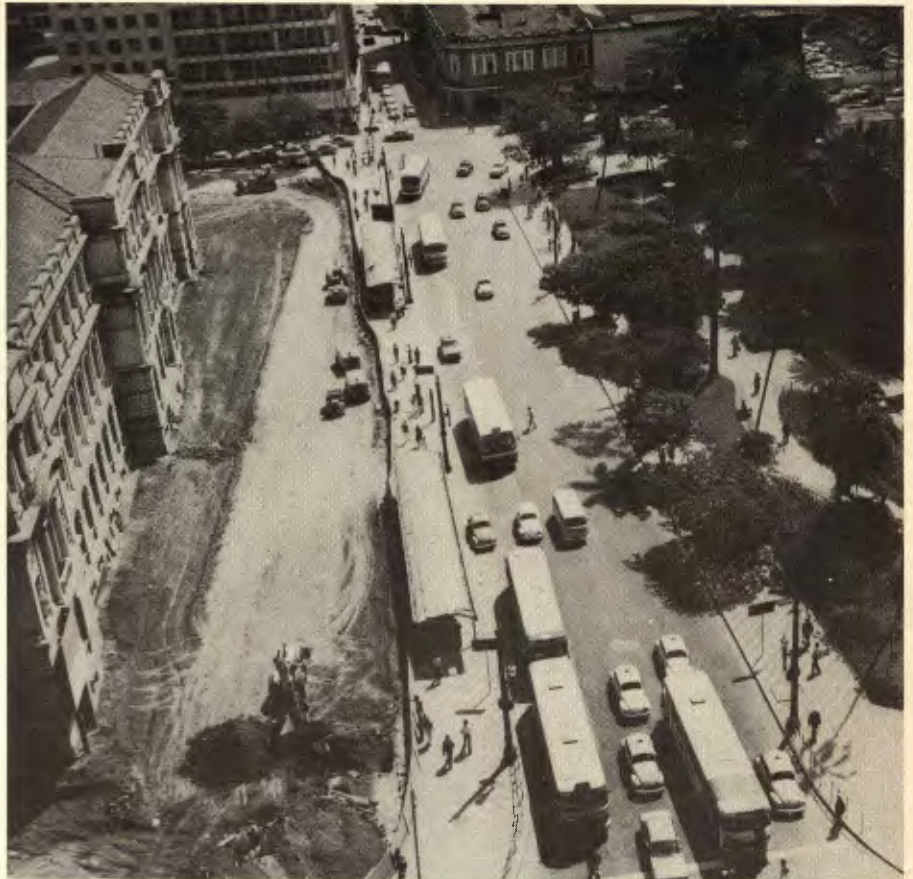
Construção do metrô paulistano: início das obras da estação Praça da República
