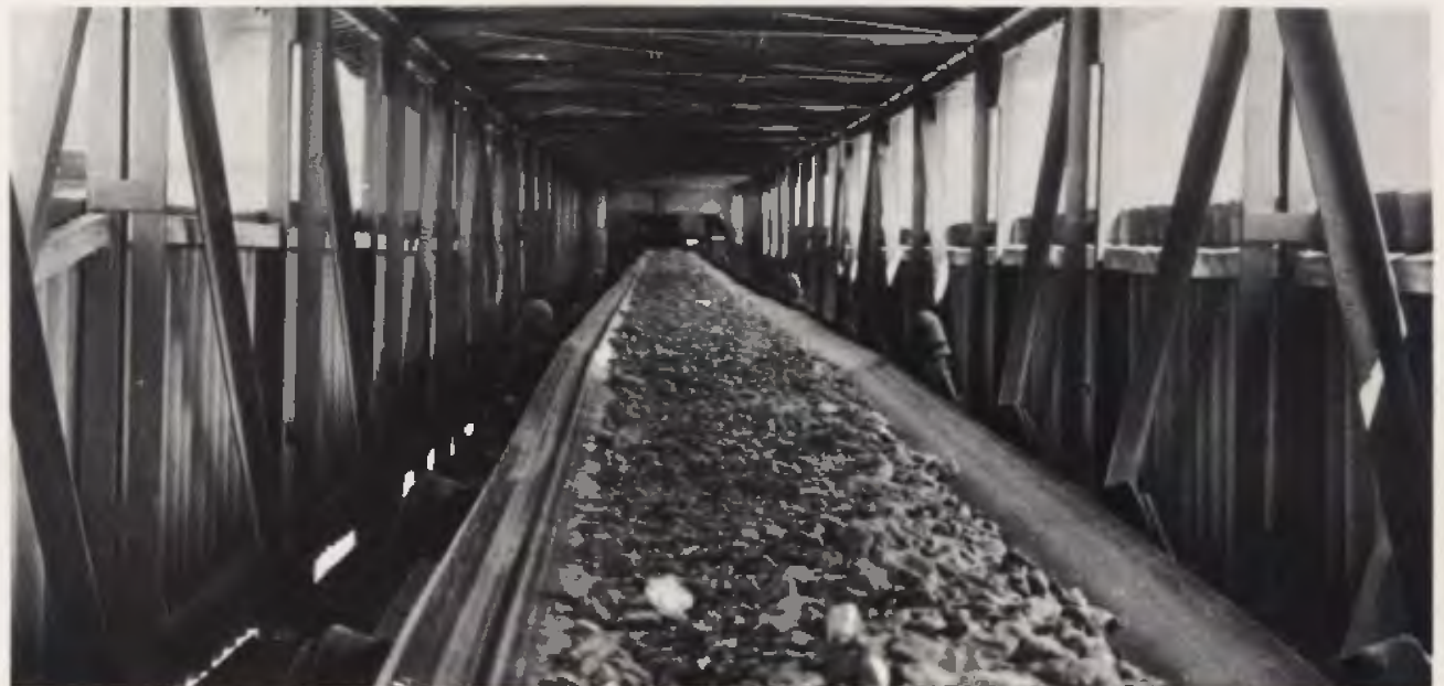
Correias: indicadas para vencer grandes distâncias, transportando elevados volumes de material a granel.
