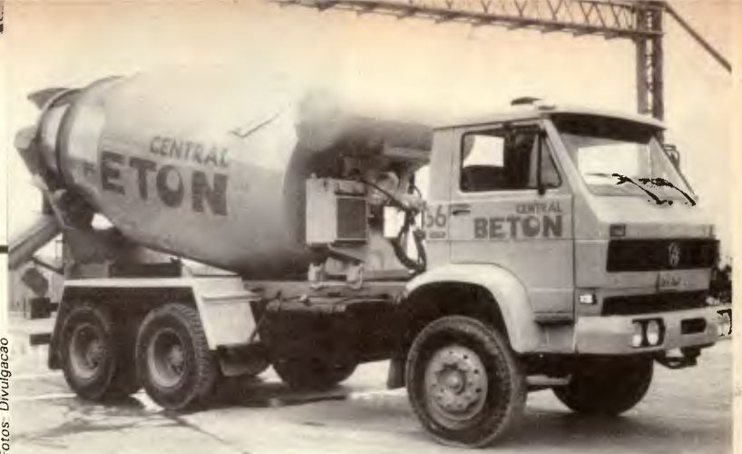
Suspensão e mola reforçadas adequam o 24-220 ao trabalho na construção
