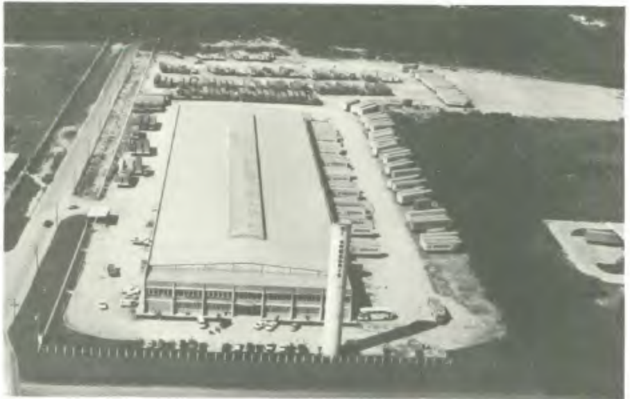
Terminal rodo-marítimo-fluvial de Manaus: o centro nervoso da Di Gregório
