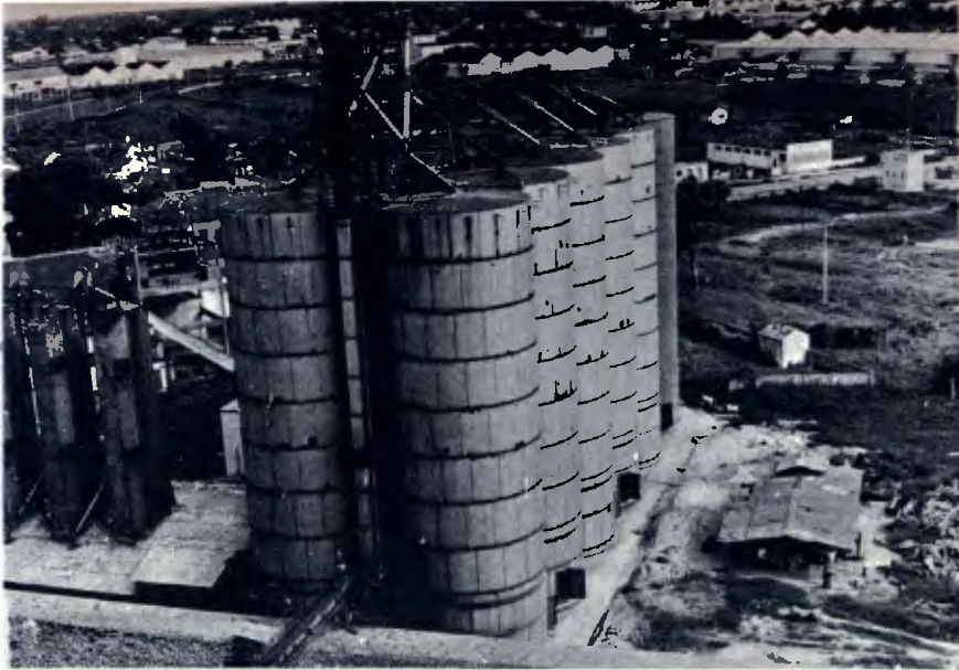
O silo: 51,5 m de altura e dezesseis células de 23,65 m de diâmetro.
