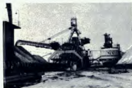
Técnica de fabricação de correias avançou. E os pórticos já têm boa receptividade.
